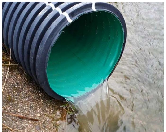
Das gefasste Fremdwasser, welches vorher in das örtliche Kanalsystem eingeleitet wurde, wird nun über eine neu verlegte Leitung dem Kulturgraben und im weiteren Verlauf dem Pfarrbach zugeführt.
